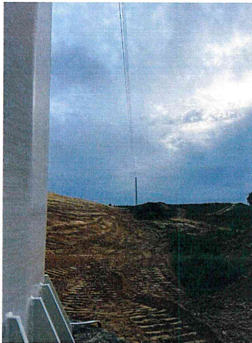
Widok badanego przęsła 31A-31B
