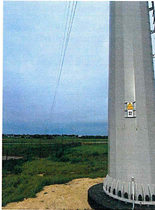
Widok badanego przęsła 32-33
